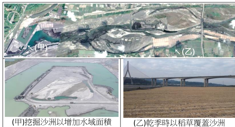
圖 26 二重溪河段的抑制揚塵工法
