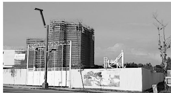
圖 7 正在興建中臺灣電影中心
